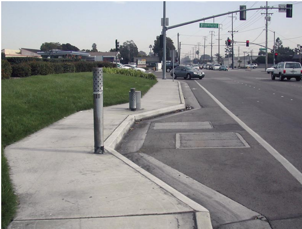
Pozo de inyección sumergido en la barrera contra la intrusión salina, situado en la Avenida Ellis.
